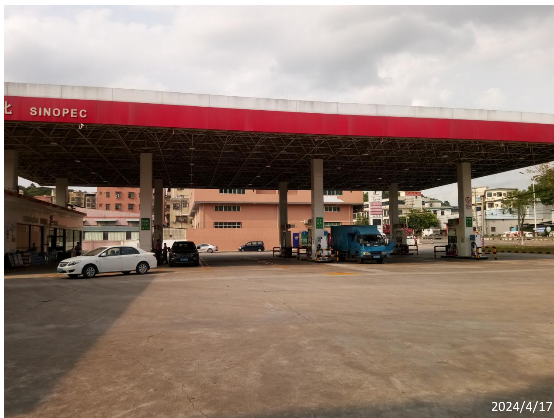
中国石化销售股份有限公司广东惠州惠阳塘口加油站现场照片
