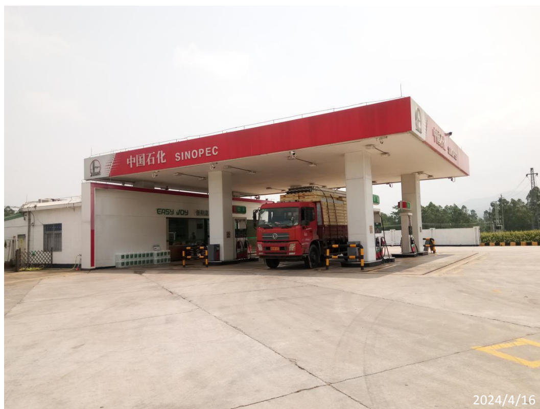
中国石化销售股份有限公司广东惠州博罗旭皓加油站现场照片
