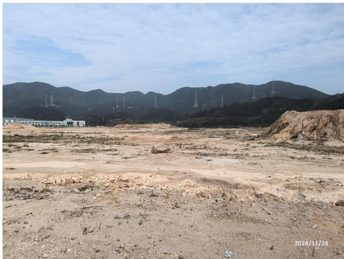
江门市德众泰新材料有限公司德众泰年产3万吨特种高分子材料生产基地项目现场照片
