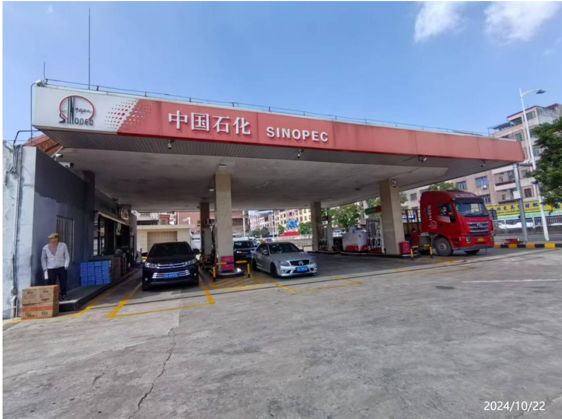
中国石化销售股份有限公司广东东莞企石东平加油站现场照片
