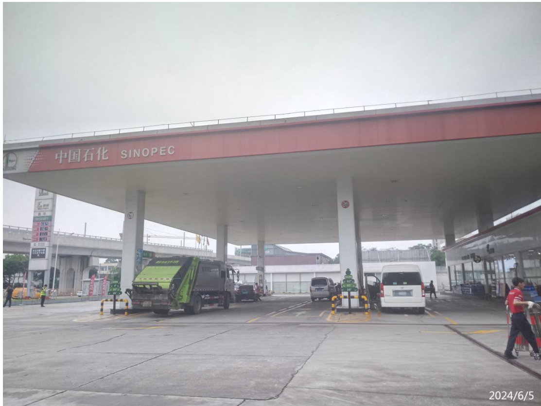
中国石化销售股份有限公司广东东莞道滘昌平加油站现场照片
