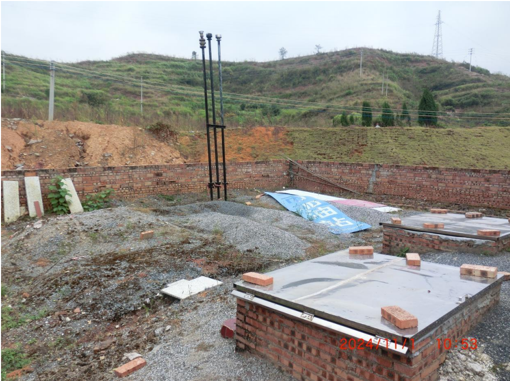
现场勘察影像：（现场勘察时间：2024年11月1日）
