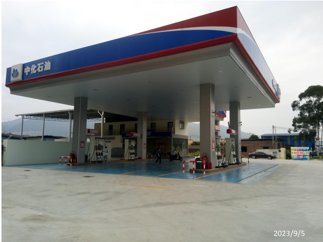
佛冈源健加油站有限公司现场勘察照片：
