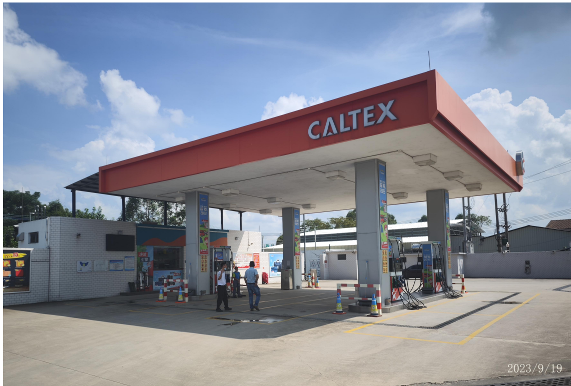
恩平加德士石油产品有限公司君堂加油站现场勘察影像：
