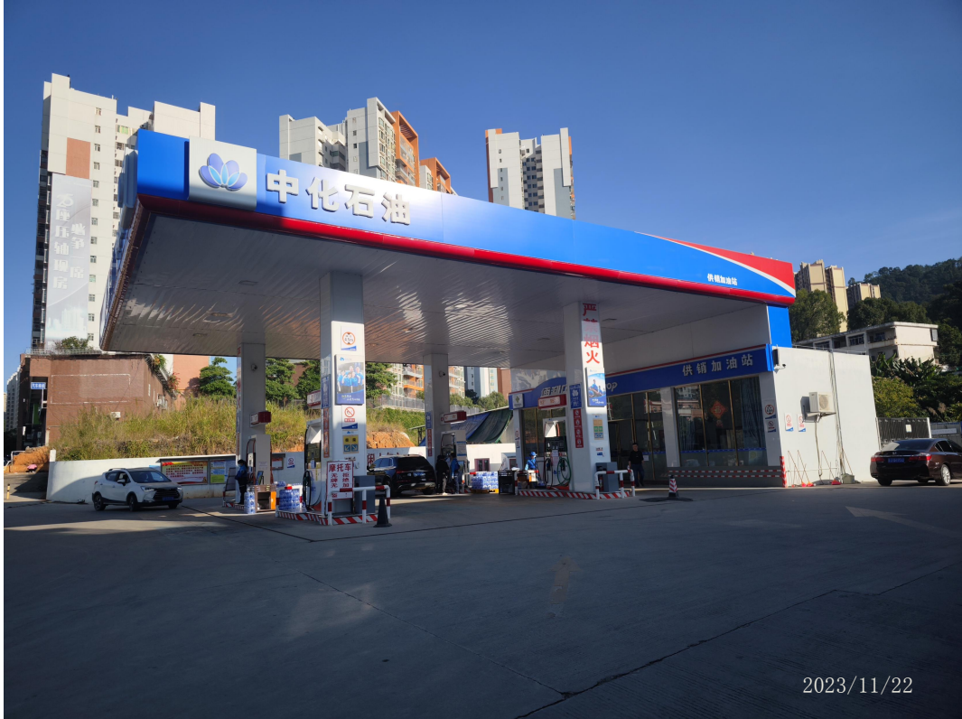
龙川县供销储运公司加油站现场勘察影像：
