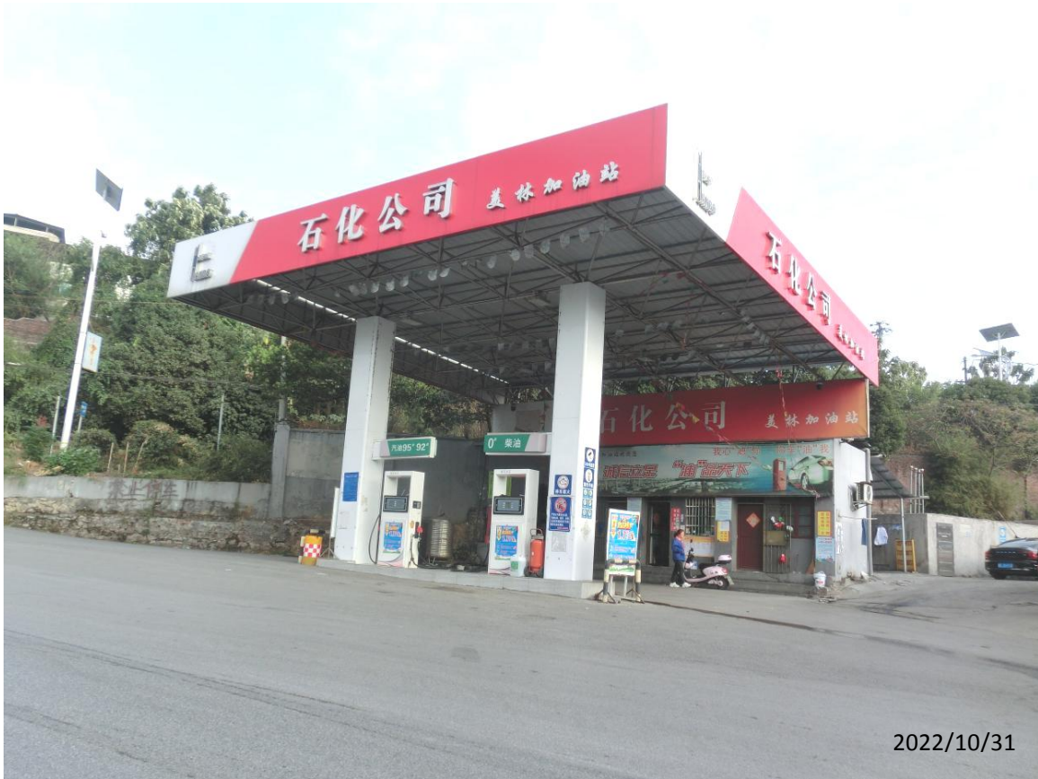
宜章县梅田镇美林加油站现场勘察影像：
