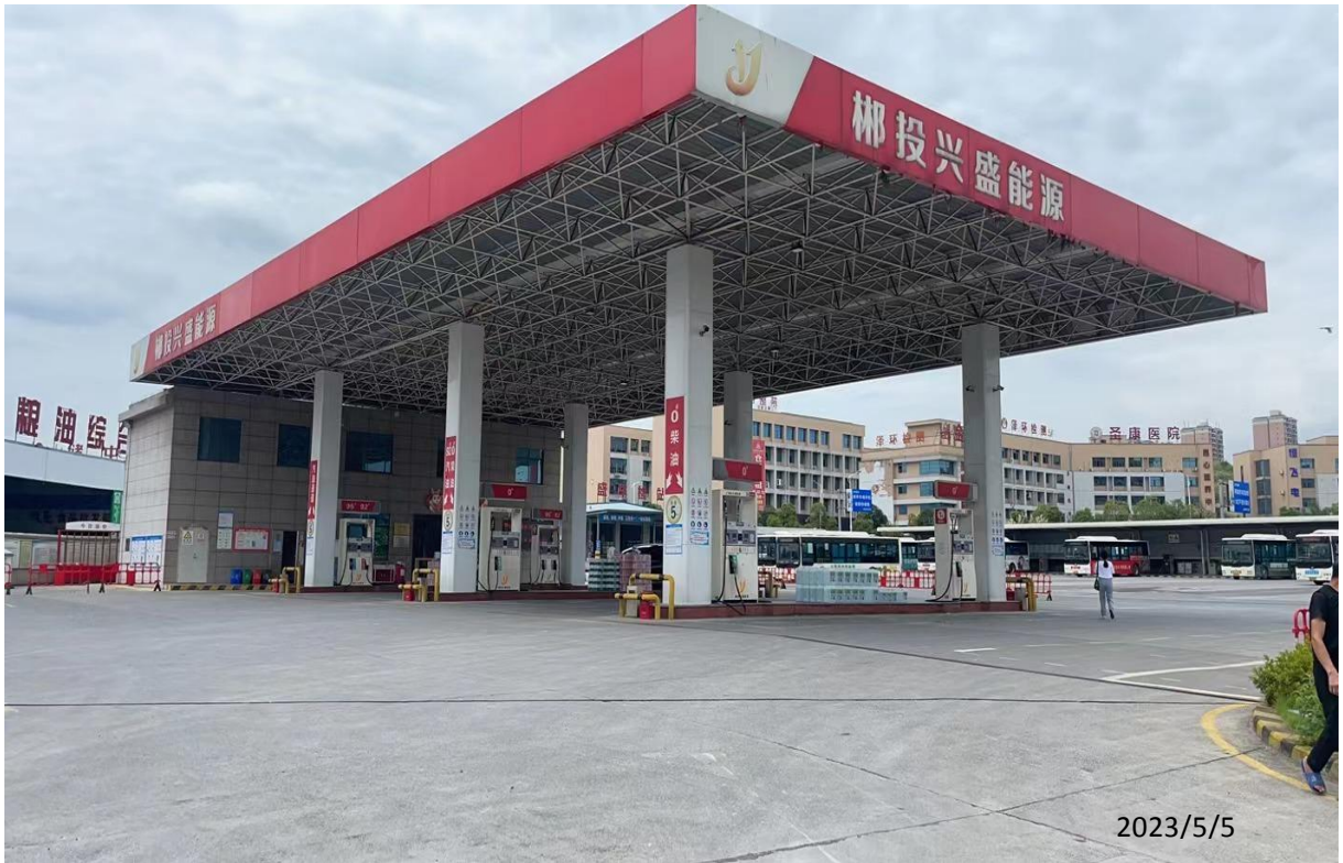
郴州郴投兴盛能源有限公司现场勘察影像：
