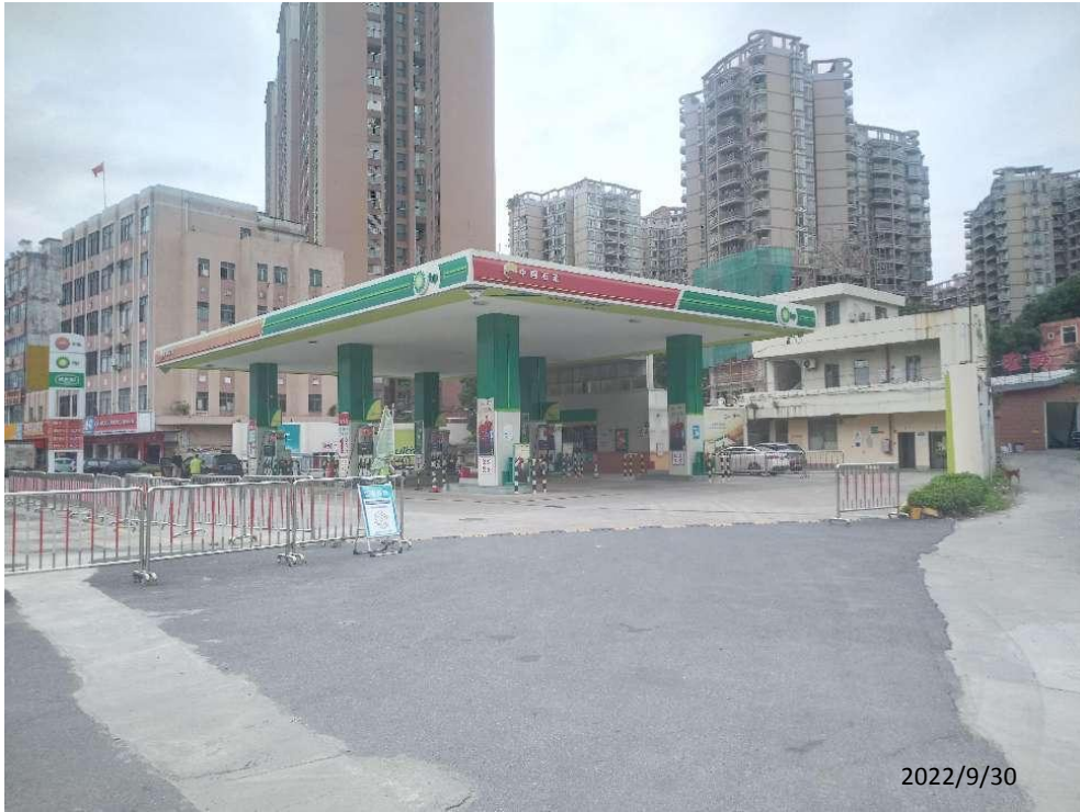
中油碧辟石油有限公司东莞丰兴加油站现场照片：
