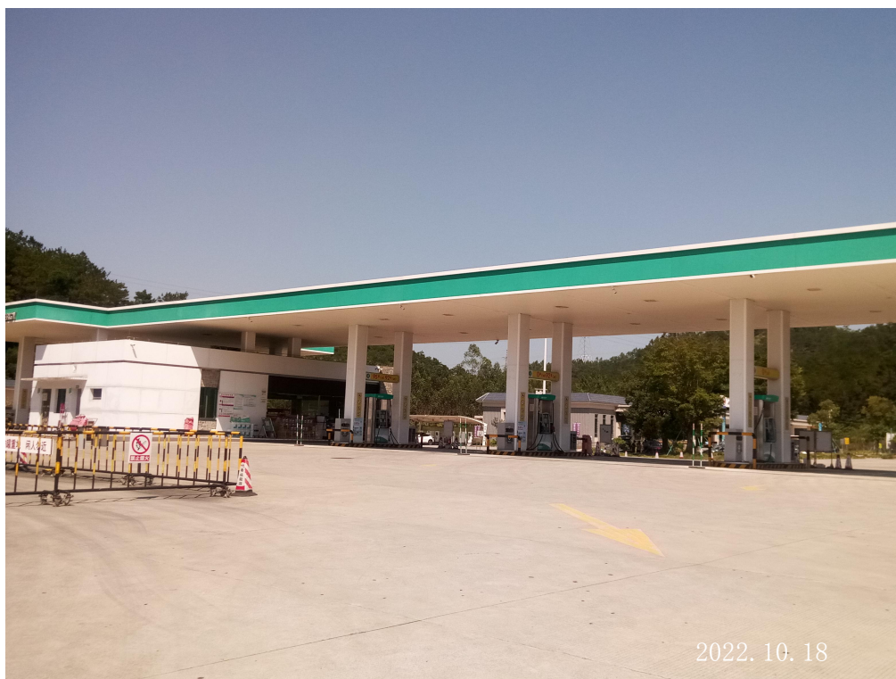
广东通驿高速公路服务区有限公司司前服务区加油站北站现场勘察影像：
