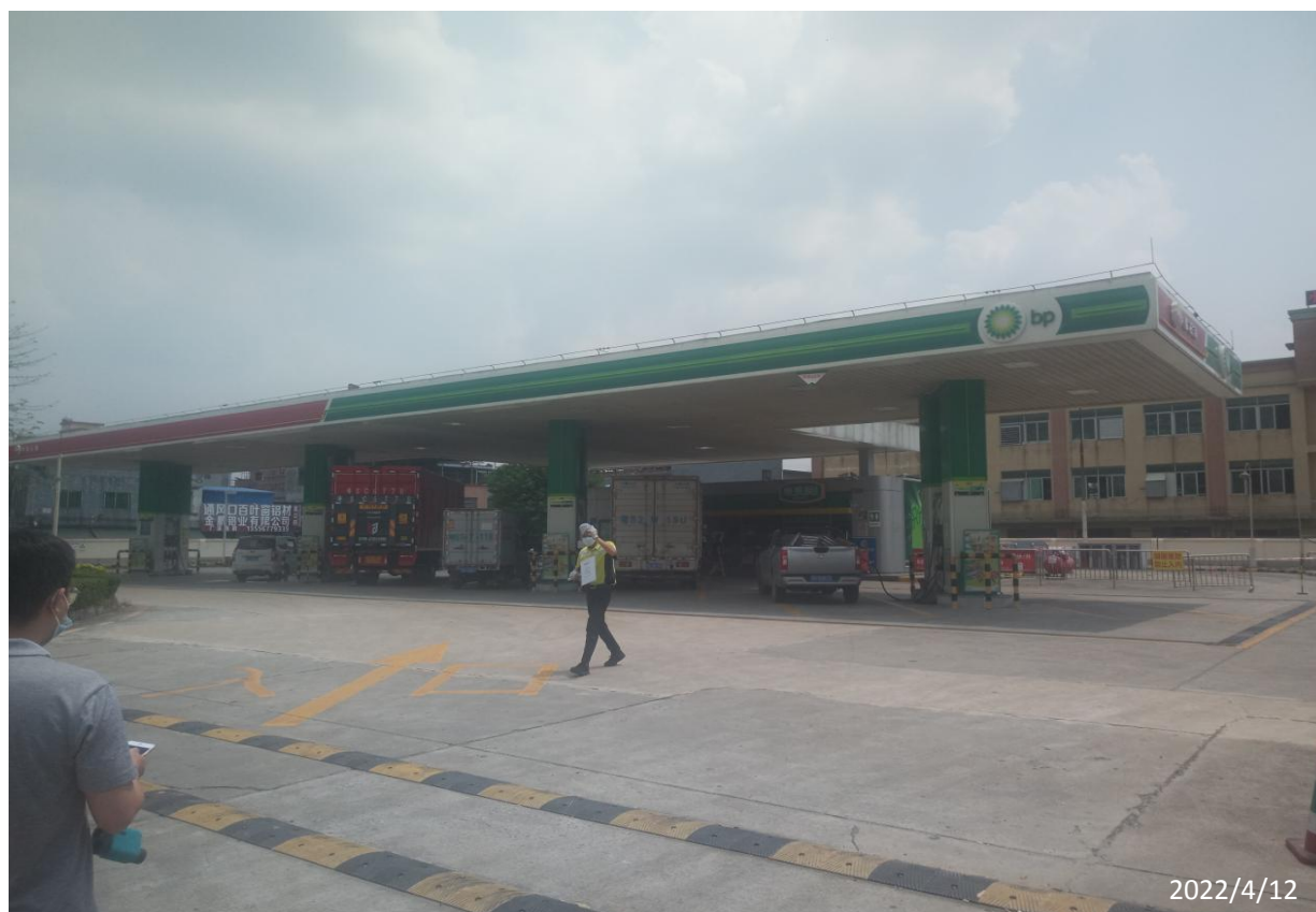
中油碧辟石油有限公司东莞英姿加油站现场勘察影像：
